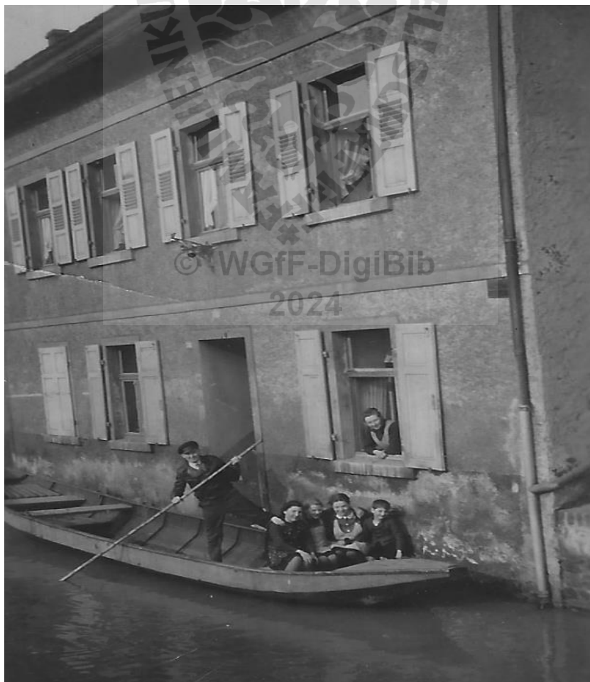
Hochwasser 1942 in Hammerstein an der B 42
